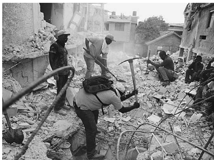
首都ポルトープランスにて、地震で瓦礫と化したビルを掘り、親族を探す男性(1月16日)。 ©UNICEF/NYHQ2010-0024/LeMoyné
